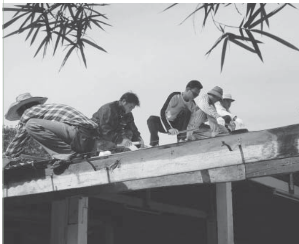
พนักงานจากเมอร์ค ประเทศไทย เข้าร่วมในโครงการ พนักงานอาสาสมัคร ทำการซ่อมแซมปรับปรุงโรงอาหาร โรงเรียนบ้านโปร่งเกตุ จ.ฉะเชิงเทรา
